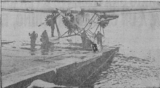
Este hidroplano metálico de tres motores, el más grande que posee la marina norteamericana, acaba de ser ensayado con buen éxito. Puede transportar veinte pasajeros. Puede transformarse en ambulancia, avión de combate y ser fácilmente convertido en anfibio
